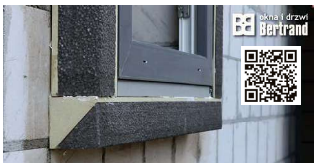
Montaż systemem MOWO
