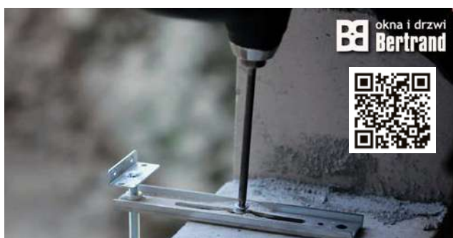
Montaż wysunięty w przestrzeni izolacji budynku na konsolach
